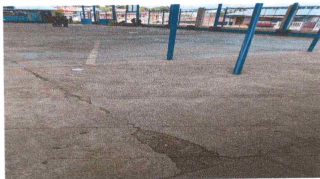
Foto 2: Sustrucción de piso por torta de concreto
