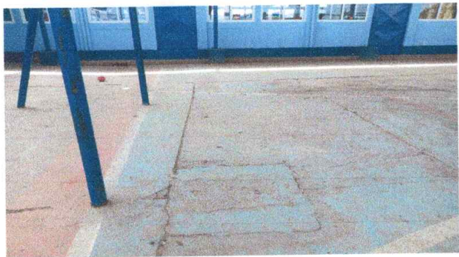
Foto 1: Sustrucción de piso por torta de concreto
