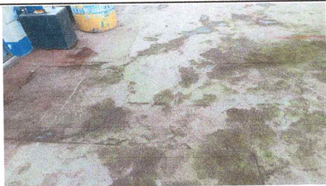
Foto 4: Sustrucción de piso por torta de concreto
