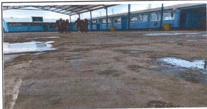
Foto 5: Sustrucción de piso por torta de concreto
