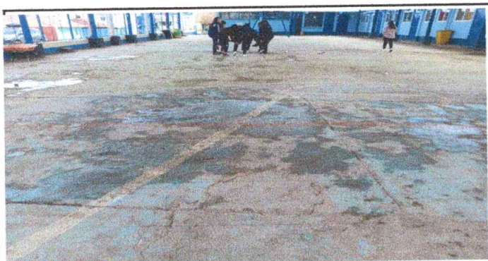
Foto 3: Sustrucción de piso por torta de concreto
